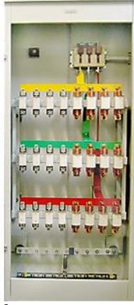
Участнику необходимо установить в силовой щит предохранители, в зависимости от сечения отходящего проводника в соответствии с требованиями нормативной документации по длительно допустимым токам. Выбранные токовые значения предохранителей должны быть вписаны в однолинейную схему.
