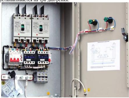
Участнику, в отведенное время, необходимо произвести монтаж схемы автоматического включения резервного питания выключателя (АВР) с соблюдением требований по безопасности согласно принципиальной схеме с учетом селективности, нагрузки и сечения проводников. Напряжение на ЭЩ не подается, корректность проверяется визуально и путем прозвонки. Произвести выбор необходимых материалов и инструментов.
